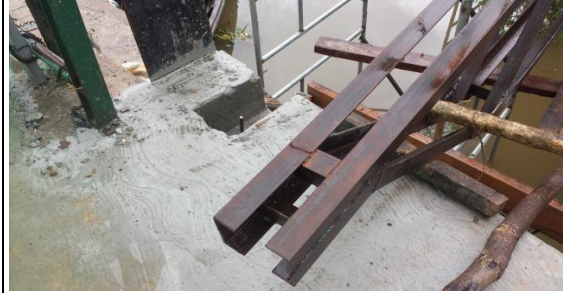
Foto 16: Concreto endurecido apoyo K0+000 para cercha metalica
