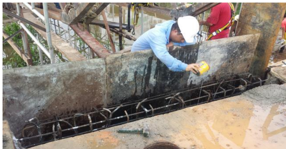
Foto 15: Refuerzo apoyo K0+000 para cercha metalica
